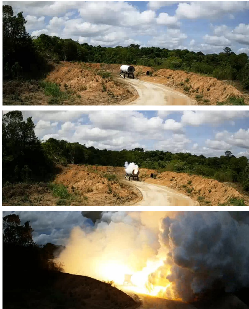
Figure 10 : Opération de destruction du segment S2 n°125 sur l'ADP le 25 novembre 2016
