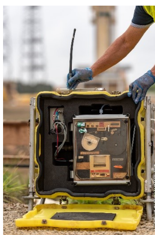
Figure 5 : SPM en cours de mise en place
